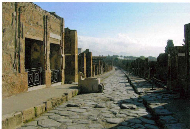
A65 Der römische Strassenbau war von hoher Qualität. Die Strassen in den Städten hatten Trottoirs und Fussgängerüberquerungen. Ein Netz gut ausgebauter Landstrassen verband das Reich. Hier: Strasse in Pompeji.
