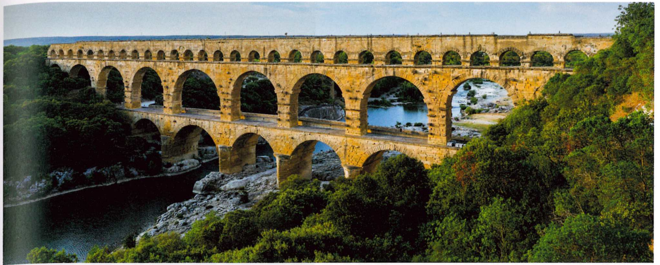
A66 Die römische Pont du Gard in Südfrankreich. Das 49 Meter hohe Aquädukt stammt aus dem 1. Jahrhundert n. Chr. und war Teil einer 50 Kilometer langen Wasserleitung von einer Quelle nahe Uzès bis nach Nîmes. Das Video beschreibt eine Inschrift aus der Provinz Alpes Graiae, die etwas weiter nördlich in den französischen Alpen liegt.
